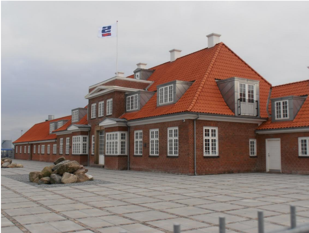
Hirtshals Station, der er nyrestaureret og nu hovedsæde for Skagerak Group, blev bygget som byens første havneadministration
