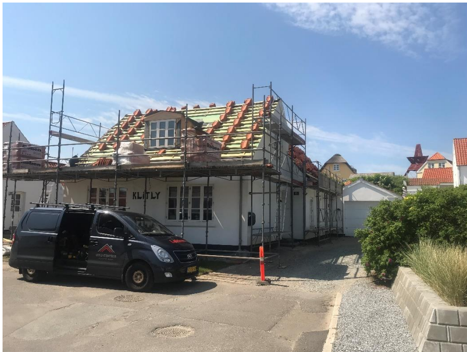
Norgesvej 32 får nyt tegltag, og kvistene bliver ændret til et tidstypisk udtryk. Der er også kviste på husets bagside og på sidebygningen.
